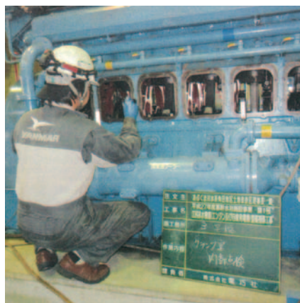
エンジン整備補修（第3号エンジン）
