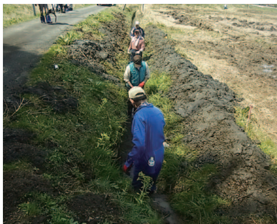
水路の泥上げ
