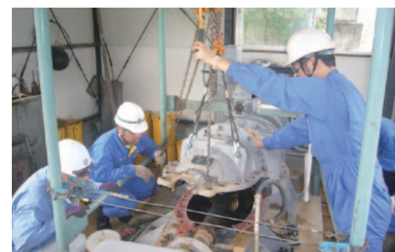
㈱谷工機社による花島揚水機場開放点検指導
