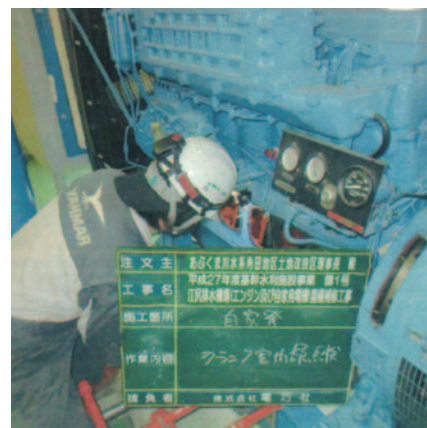
自家発電機整備補修
