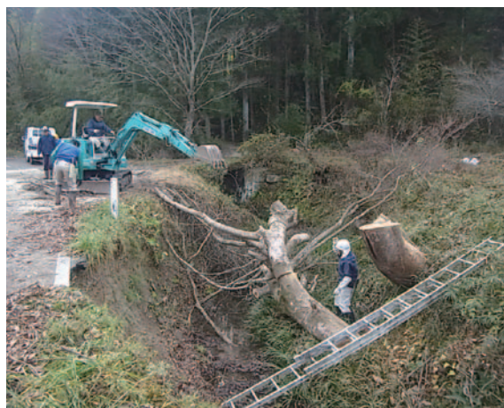
川の支障木伐採
