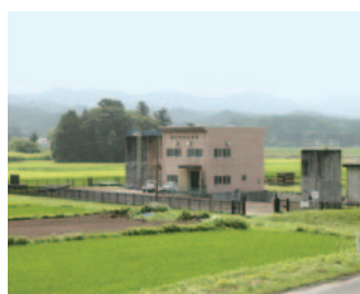
新小斎揚水機場
