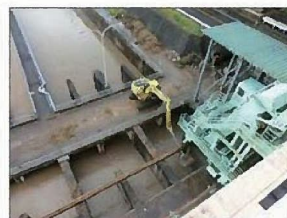
バックホウでの除塵作業
