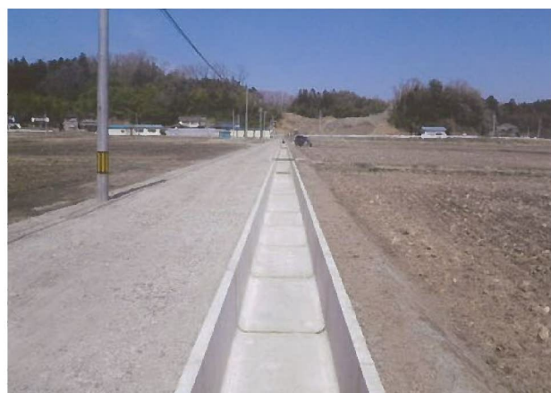
用水路工（完成）
