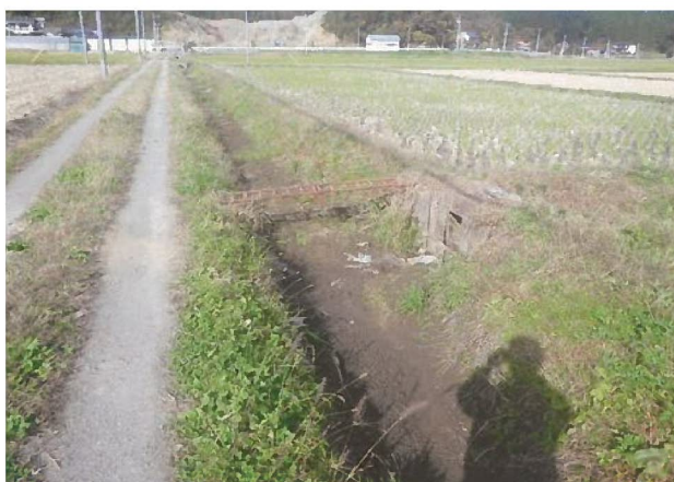
分水槽工（施工前）
