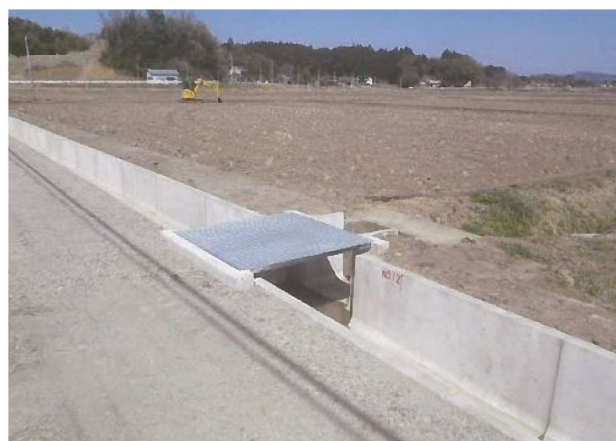
分水槽工（完成）
