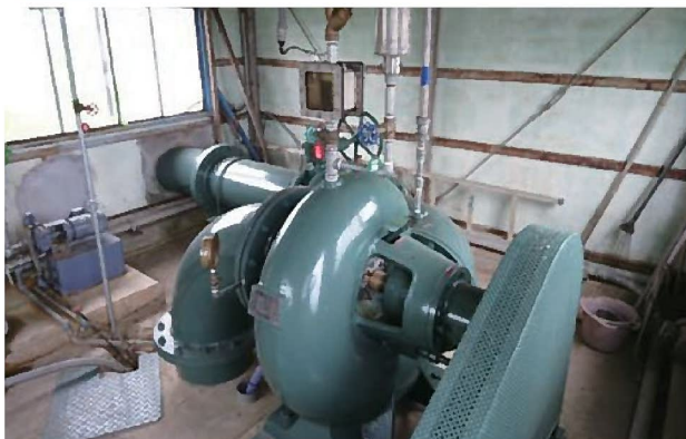
北大坊揚水機場 ポンプ設備整備補修 事業費 4,989,600円 (負担割合：国30%、県30%、地元40%)
