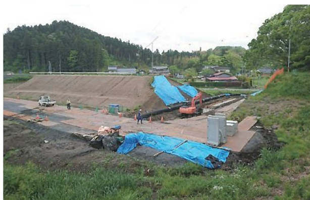
猿田ため第2ため池改修工事 事業費125,156,880円 (負担割合：国50%、県33%、市17%)
