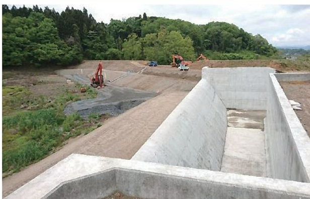
仙石ため池改修工事 事業費210,305,160円 (負担割合：国50%、県33%、市17%)
