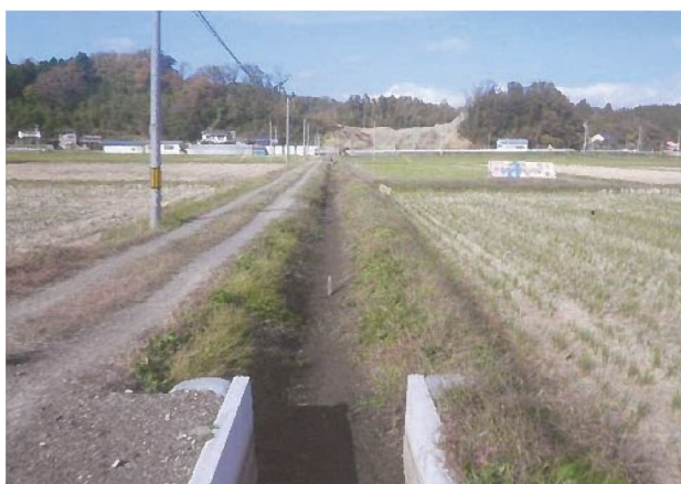
用水路工（施工前）
