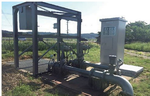
日向前揚水機場 ポンプ設備整備補修 事業費 10,184,400円 (負担割合：国30%、県30%、地元40%)
