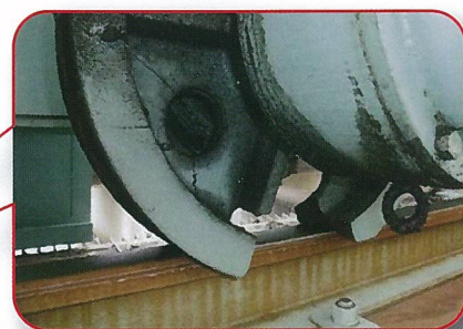
除塵機設備の車輪破損
