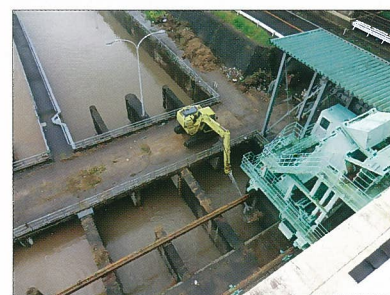
バックホウでの除塵作業
