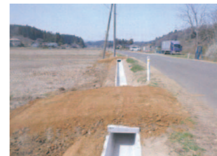
用排水路工(大内地区) 事業費 10,011,600 円 L=658m (負担割合: 国 55%、地元 45%)
