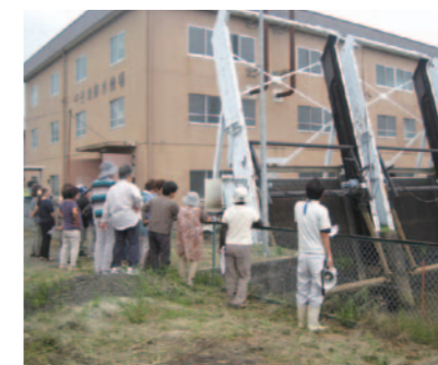
角田市枝野沼尻排水機場
