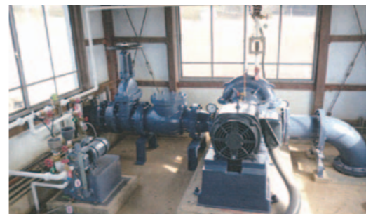
三島揚水機場 両吸込渦巻ポンプ(250φ30kw)整備補修 事業費 3,294,000 円一式(角田市、島田地区) (負担割合: 国 30%、県 30%、地元 40%)
