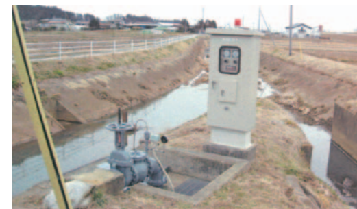
木沼第一揚水機場 水中ポンプ(200φ15kw)整備補修 事業費 4,644,000 円一式(丸森町、木沼地区) (負担割合: 国 30%、県 30%、地元 40%)
