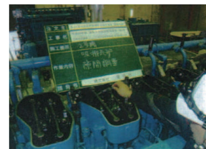
江尻排水機場(エンジン及び自家発電機)整備補修工事 事業費: 9,464,000 円 一式 (負担割合: 国 30%、県 30%、市 30%、地元 10%)
