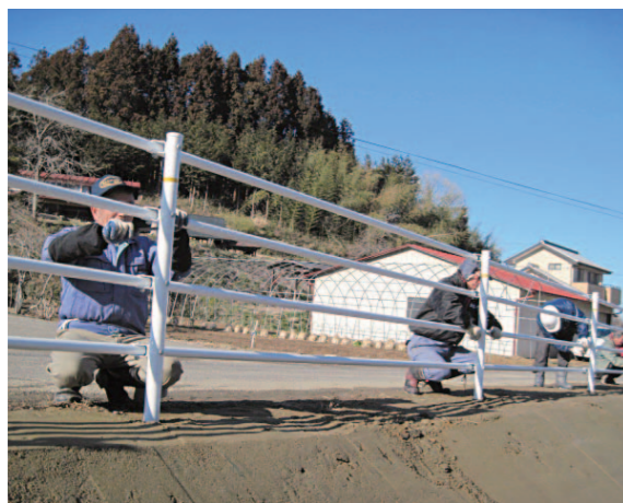
ガードパイプの設置
