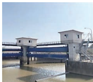
第3,4制水門ゲート補修
