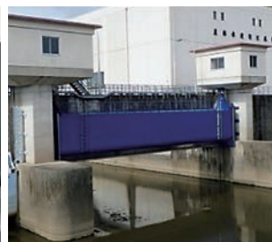
第1制水門ゲート補修
