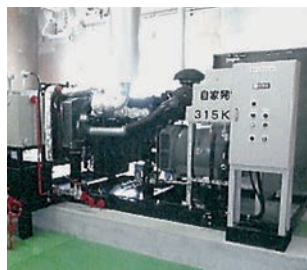
自家発電機更新
