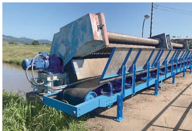
大堀除塵機整備補修工事（電動モーター更新・ベルトコンベア整備等） 事業費：11,055,000円（県75.0%、市15.0%、改良区10.0%）R4年以降
