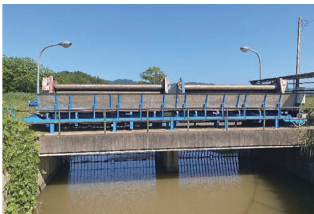
大堀除塵機整備補修工事（電動モーター更新・ベルトコンベア整備等） 事業費：11,055,000円（県75.0%、市15.0%、改良区10.0%）R4年以降
