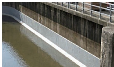
導水路補修完了
