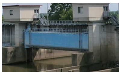
第1制水門ゲート(現況)
