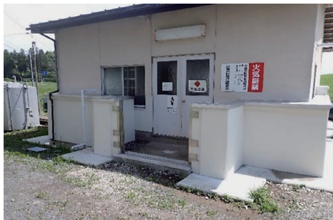
平貫排水機場外災害復旧工事(防水壁設置等) 事業費：78,299,100円
