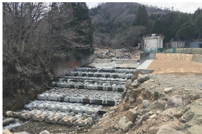
土合堰災害復旧工事 事業費：61,682,500円
