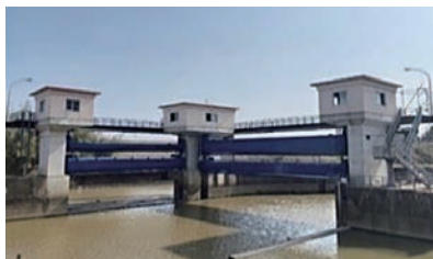
第3,4制水門ゲート補修中
